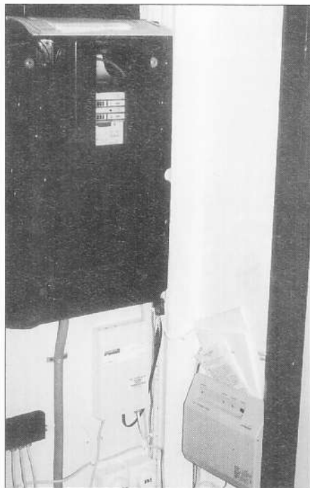
ISDN bij Populier BBS in de meterkast met links en in het midden de verschillende aansluitingen en rechts de Modivox.
